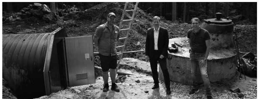
Wasserwart Johannes Schmid (v.l.), Bürgermeister Dr. Olaf Heinrich und Lothar Ilg (Leiter Bautechnik) vor dem alten (re.) und dem neuen Quellsammelschacht in Kreuzberg. Foto: Lang
